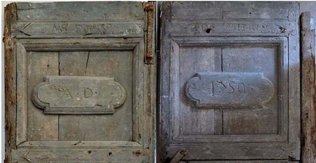
Fig. 4 Assemblaggio fotografico delle due sommità del portone d'ingresso, chiesa parrocchiale, Ruggiano.
